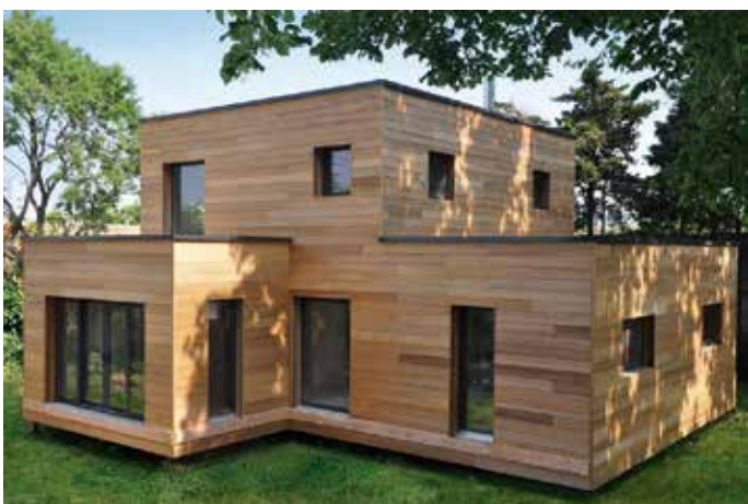
Construcción con madera maciza.
